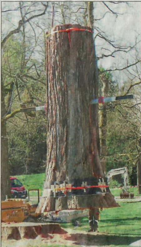
DAS BAUMFENSTER dient als Haltemöglichkeit für den Schwerlastkran.
